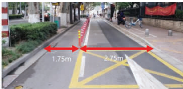
市妇幼旁的莫愁路改造后，供非机动车使用的车道1.75米，候车车辆车道2.75米
