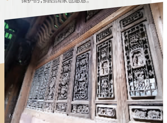
古建筑内部情况
