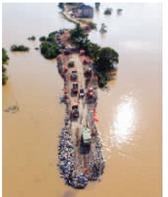
鄱阳县鄱阳镇问桂道圩堤抢险施工现场 新华社发
