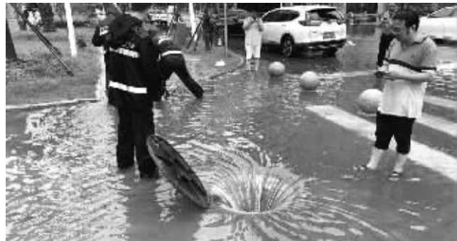
城管队员为东林古运河小学排水 城管供图
