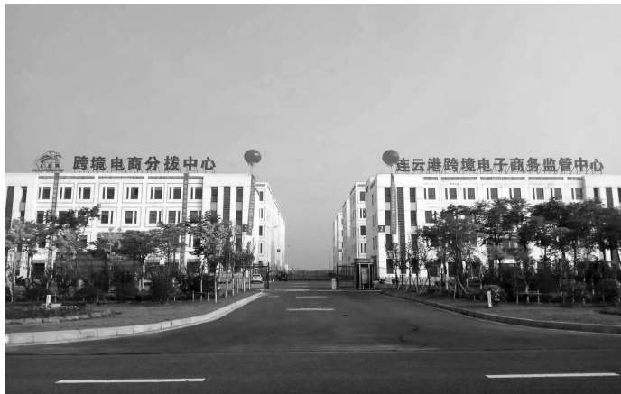
连云港跨境电子商务控制中心 通讯员供图
