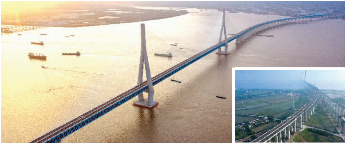
沪苏通长江公铁大桥(6月29日摄,无人机照片)
