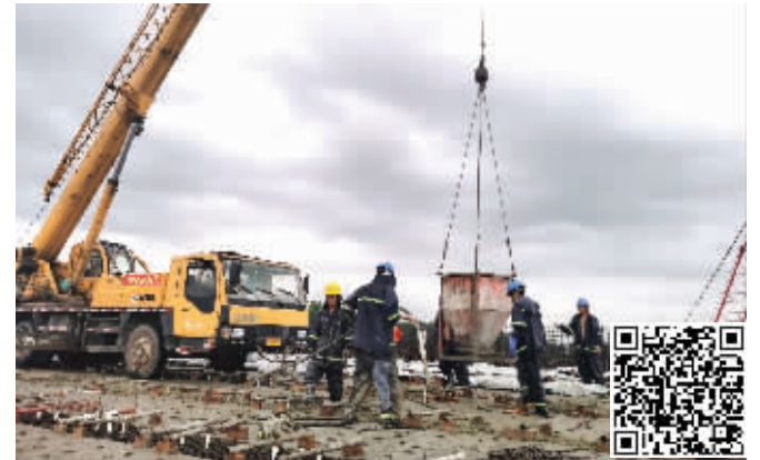
芒稻河特大桥施工现场 现代快报+/ZAKER南京记者 李娜 摄 扫码看视频
