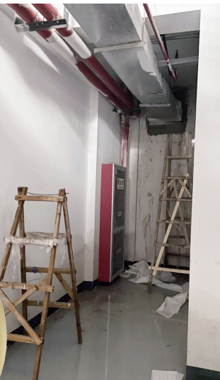
▲管道衔接处不断有水流出，地面积满了水
