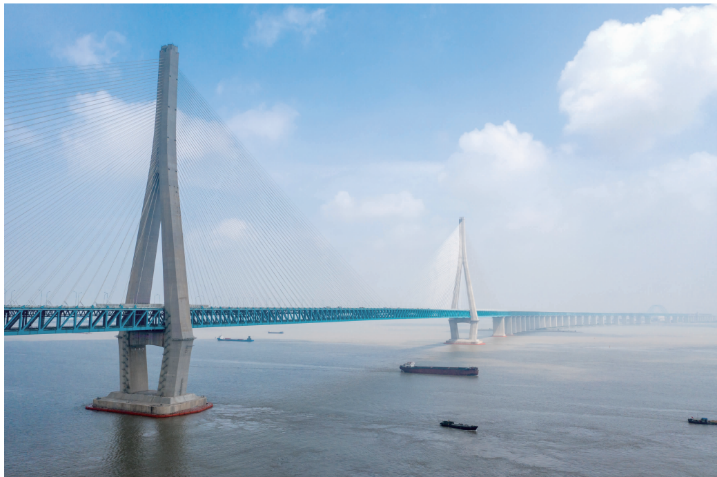
沪苏通长江大桥是世界上首座跨度超千米的公铁两用斜拉桥 江苏省交通运输厅供图
