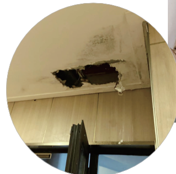
▲管道衔接处不断有水流出，地面积满了水
