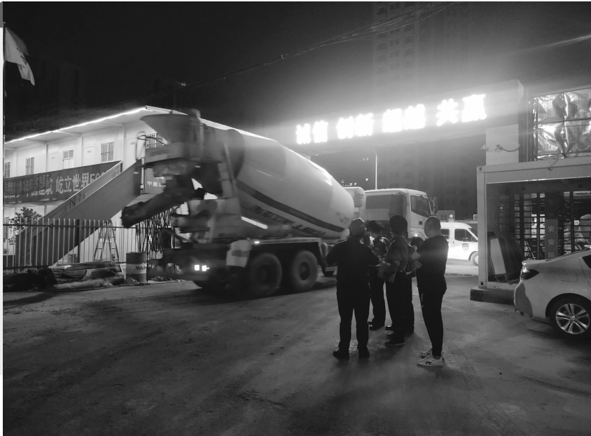
查处夜间施工现场 滨湖城管供图
