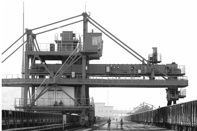
港口塔吊在装车 通讯员供图
