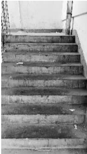
洪武路311号的楼梯间
