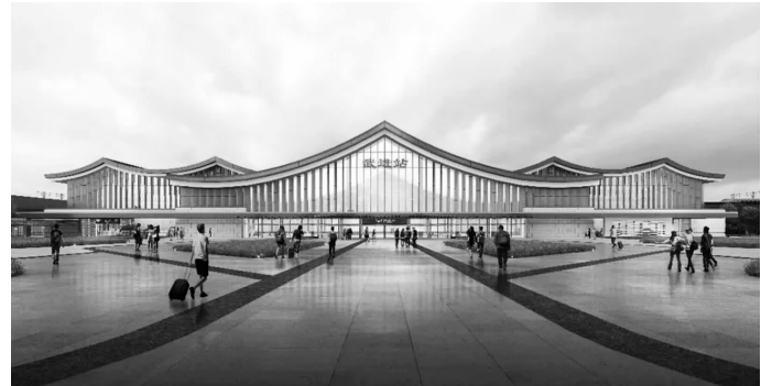
苏南沿江城际铁路武进站外观设计 通讯员供图
