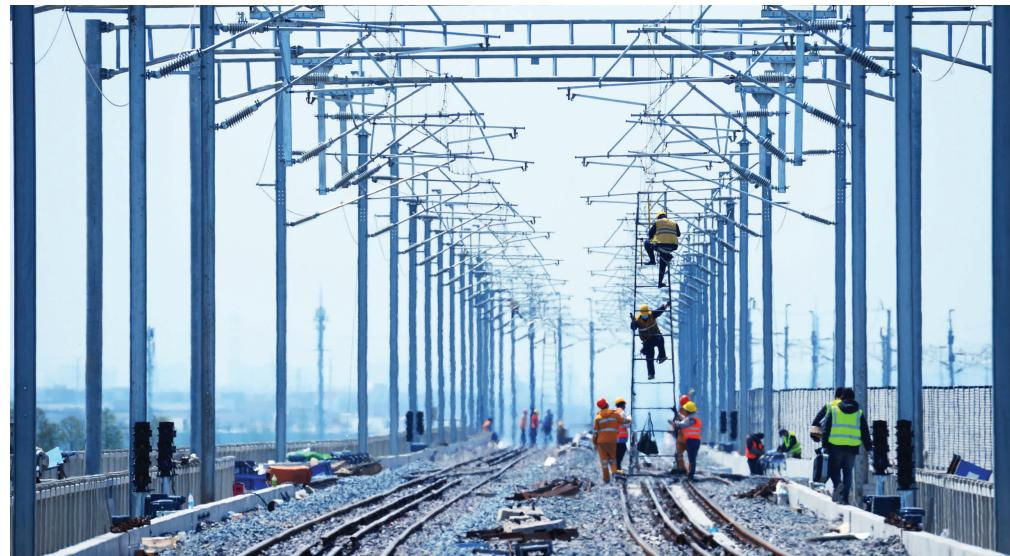
工人正在进行铁路接触网静态验收 中铁电气化局供图
