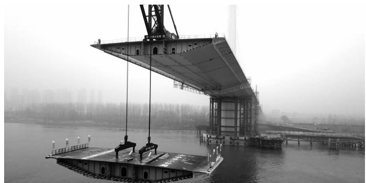
五桥南塔一块钢箱梁正从运梁船上吊起
