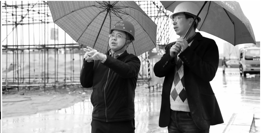
许烨在华天的工地现场推进项目
