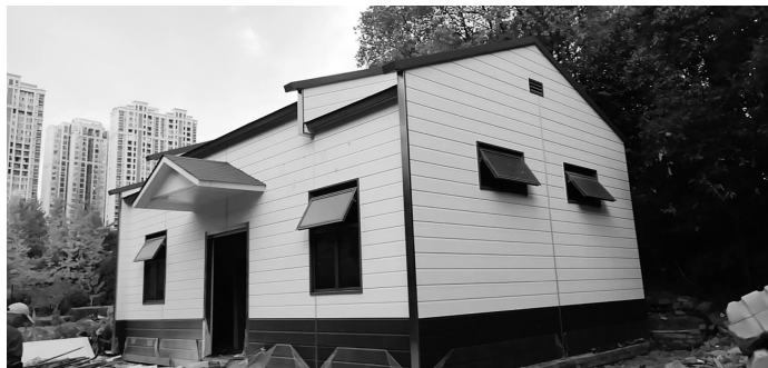
采用装配式工艺建造的公厕 滨湖城管供图
