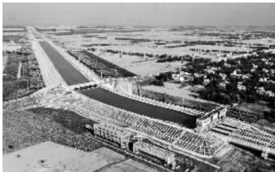
沙河渡槽 南水北调中线建管局宣教中心供图
