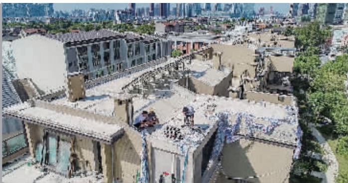
施工队正在拆除楼顶违建 厉坤坤 摄
