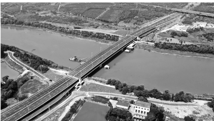
吉印大道跨秦淮河桥建成通车 江宁开发区供图
