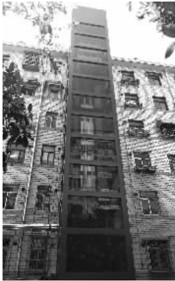
增设的电梯安装完成 通讯员供图
