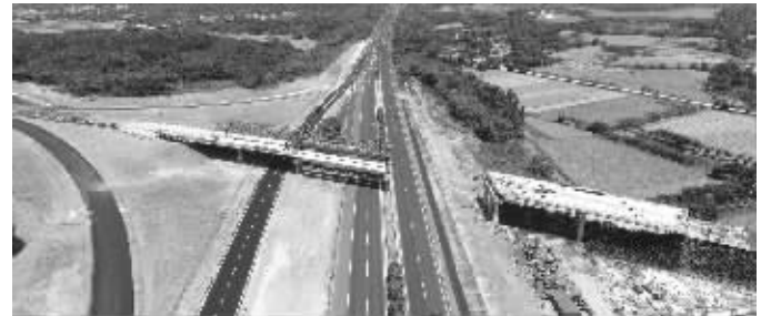
曹山互通C匝道跨高速桥梁架梁设现场 张国芳 摄
