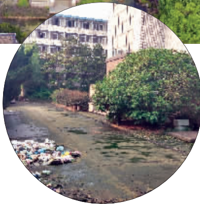
地面除了水渍,还有污泥和垃圾
