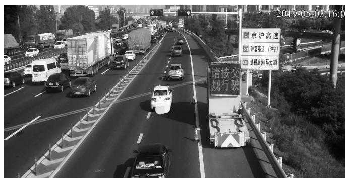
全国首个高速公路匝道智能管控系统正在工作，通过信号灯控制车流 无锡交警供图
