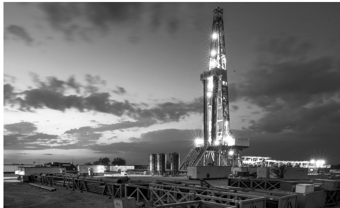
保利协鑫天然气集团钻井作业现场并架高耸 保利协鑫供图
