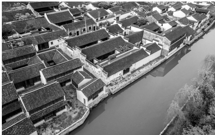
部分修缮完工的青果巷历史文化街区 晋陵集团供图
