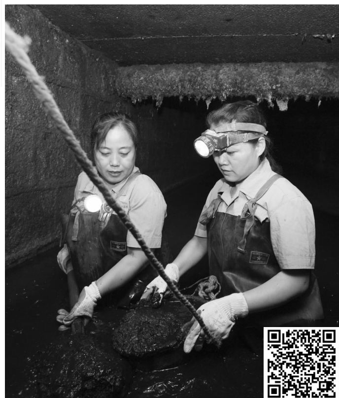
“女汉子”们正在井下清淤 徐州下水道四班供图 扫码看视频
