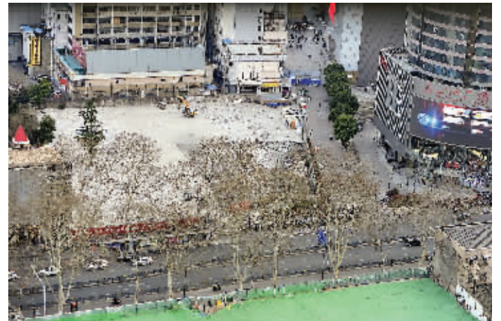
新街口原新华社江苏分社地块地下工程有望7月开工 现代快报+/ZAKER南京记者 顾炜 摄
