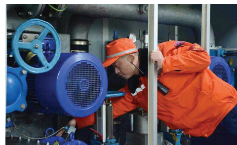
卸污工作业 通讯员供图
