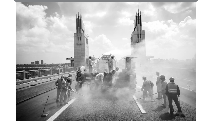
2018年9月27日，正桥钢桥面下层沥青浇筑施工 薛晓红作品
