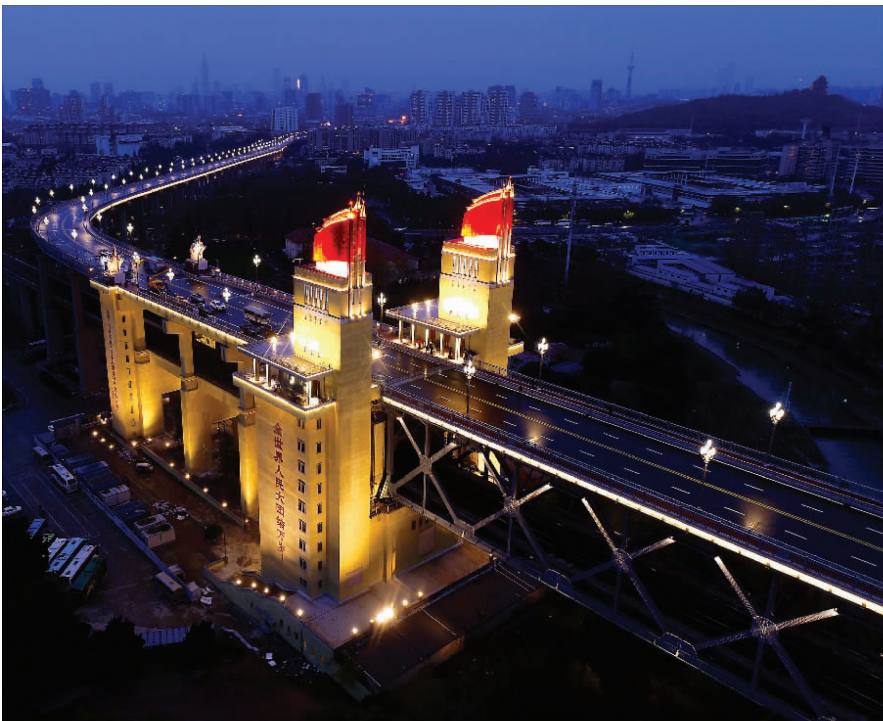
傍晚时分，南京长江大桥华灯初上分外艳丽 现代快报+/ZAKER南京记者 顾炜/摄
