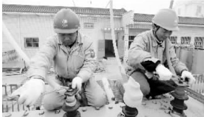
连日来,国网扬州市江都区供电公司组织施工人员对辖区内供电设施进行检修,以提高设备可靠性,迎接冬季用电高峰的到来。图为供电人员在35千伏变电站,对2号主变套管进行更换。
