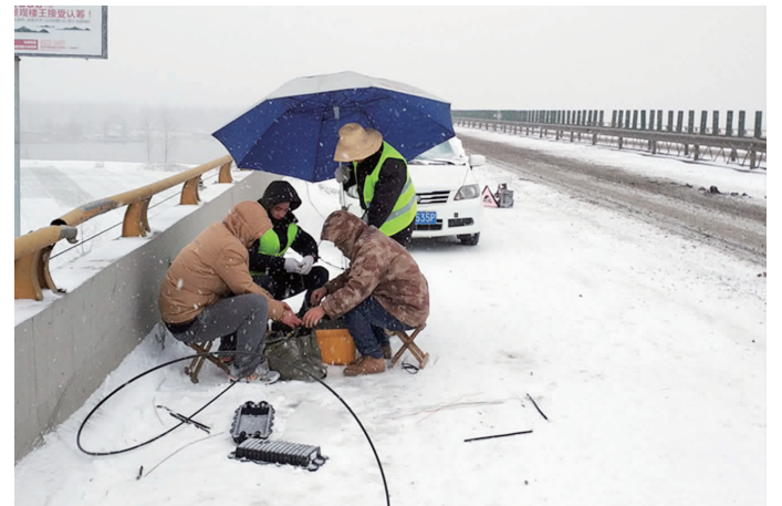
2018年1月25日7点,徐州邳州隆湖大桥上光缆被撞断,抢修人员冒着大雪蹲在地上进行融纤,一个小时后线路恢复正常 通讯员 供图
