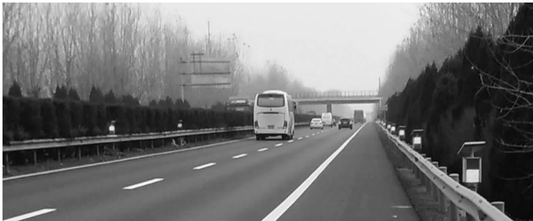
长深高速公路两侧设置的雾灯在大雾笼罩路面的时候点亮 通讯员供图
