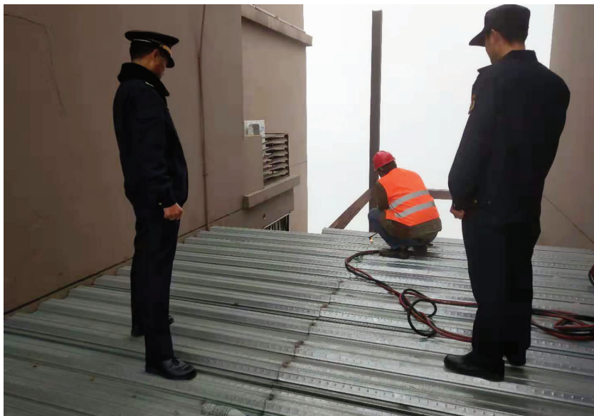
城管队员配合工作人员从外部拆除违建 梁溪城管供图
