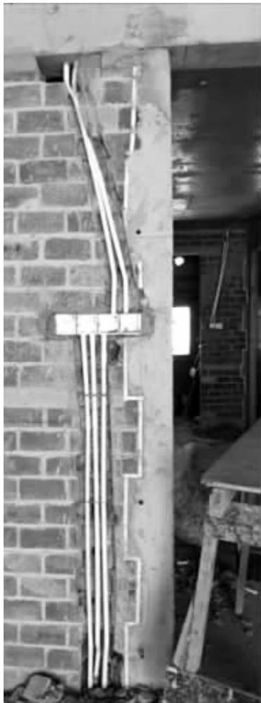
施工中的房子墙体开凿粗糙 图片由业主提供
