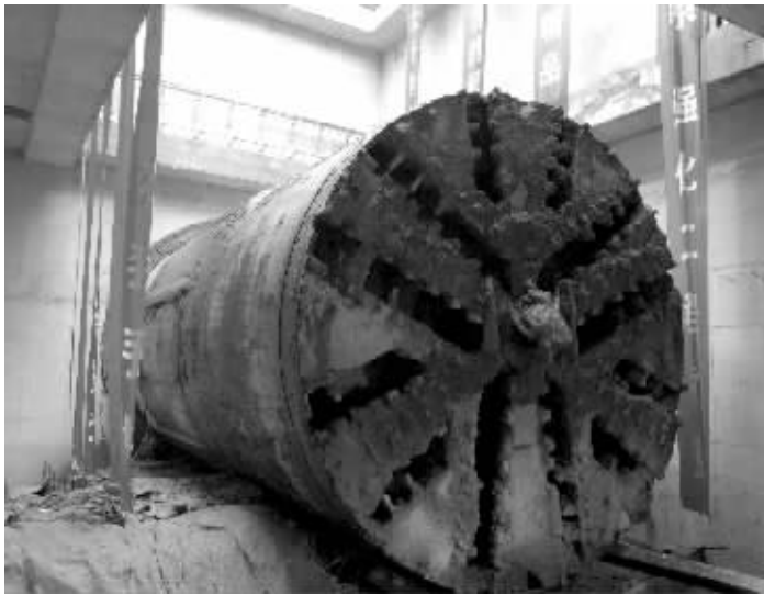
锡城地铁4号线首条盾构区间双线贯通 无锡地铁 供图
