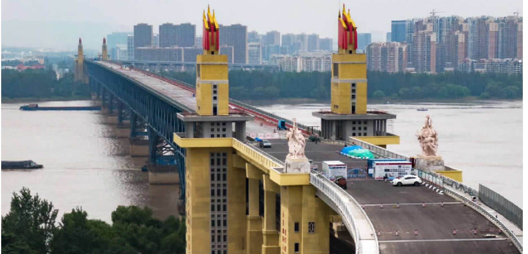
南京长江大桥正在维修,年底通车 视觉中国 供图
