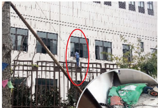
▲校舍墙外有工人在施工 ▶校保卫室里堆积着装修材料
