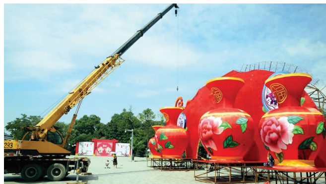
灯会施工现场
