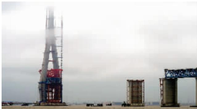
记者从江苏省交通运输厅获悉,沪通长江大桥首根斜拉索塔端挂设于8月26日顺利完成。在距离江面87米高的沪通长江大桥28号主墩墩顶,经过近8小时的施工,一条长136.6米、重量达20.04吨的“巨蟒”终于从空中垂下,这也标志着沪通长江大桥首根斜拉索塔端挂设顺利完成。
