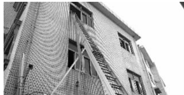
缪某从三楼窗台上坠下 消防供图
