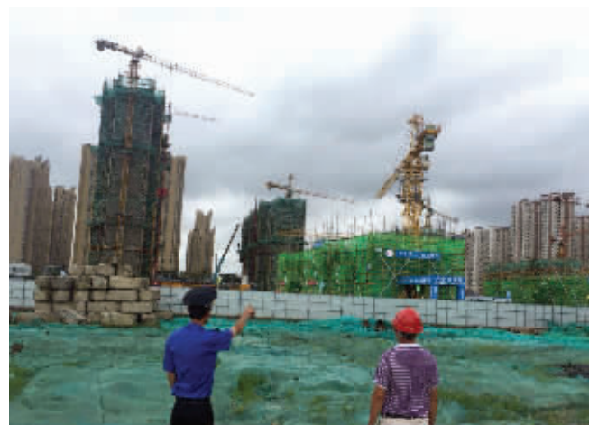
城管队员对在建工地进行安全检查
