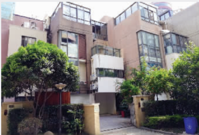
位于建邺区梦都大街126-30号的拍卖别墅 拍卖网站图片
