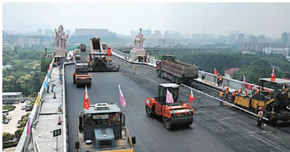
6月7日，现代快报记者从南京市公共工程建设中心获悉，南京长江大桥南引桥开始进行桥面沥青混凝土铺装施工，这标志着桥面沥青混凝土铺装正式启动。
