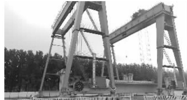
日前,连徐铁路站前I标首榀箱梁在连云港顺泰制梁场成功架设,此次架设的箱梁重达900吨,是连连云港至徐州铁路客运专线标段内首片铺设的箱梁。连徐铁路是十三五江苏省开工建设的首个铁路项目,也是以江苏省投资为主建设的首条时速350公里的高铁。
