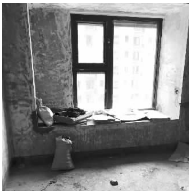
易女士家建筑材料还堆着,施工已经停下 业主供图
