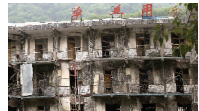
北川职业高中的废墟
