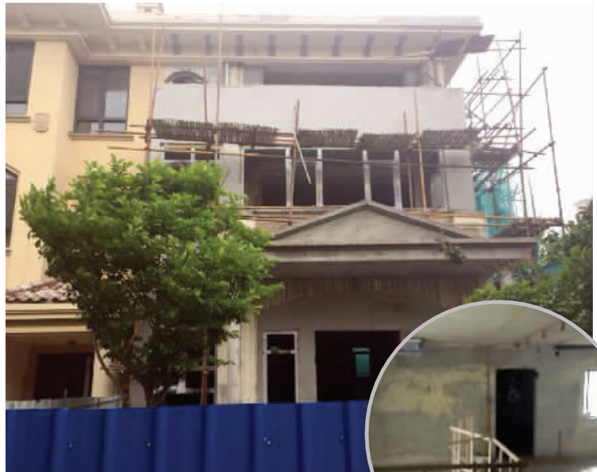
发生坠亡事故的别墅,目前装修已停工
