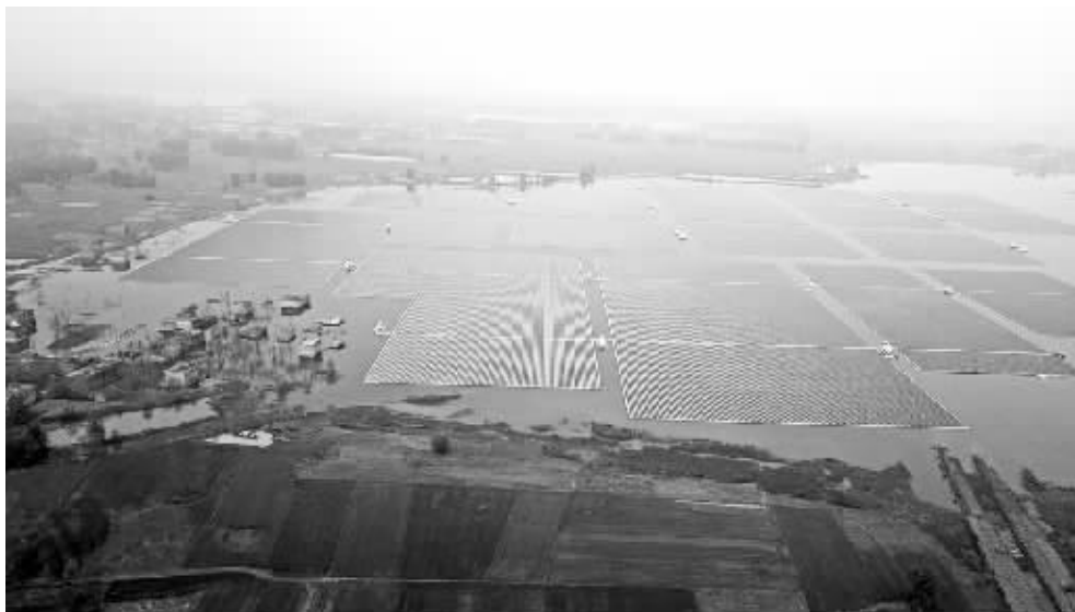
淮南水上光伏发电项目 新华网供图
