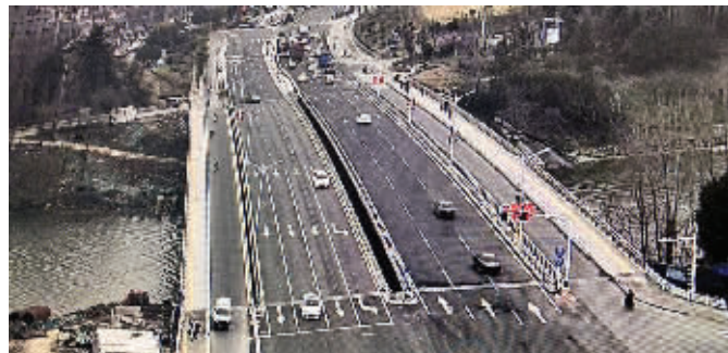
铁心桥完工后现场图 交警供图
